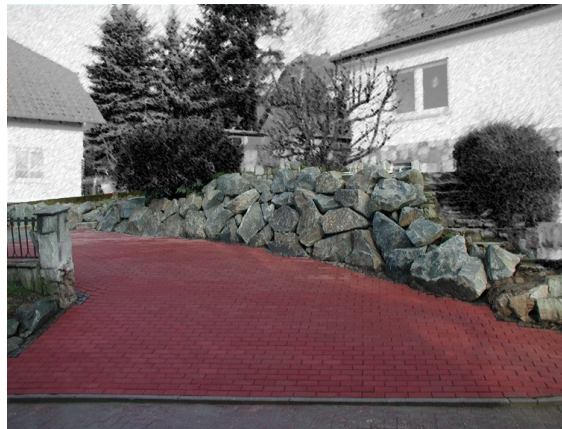
Einfahrt mit Hangbefestigung durch Felsgestein
