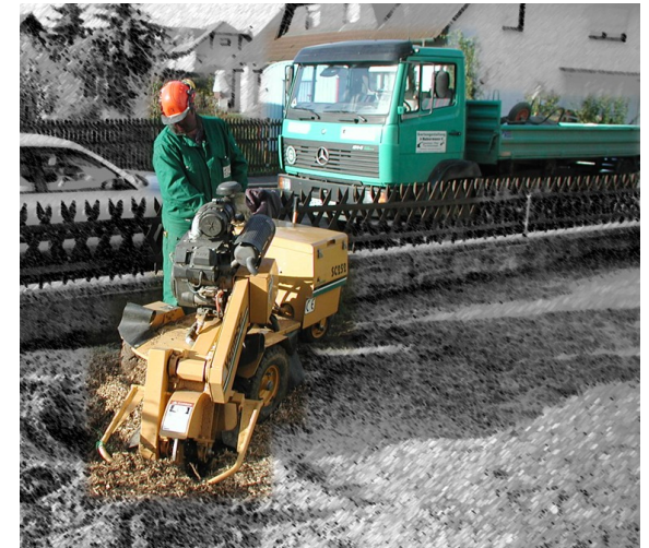
Wurzelfräse im Einsatz nach Baumfällarbeiten
